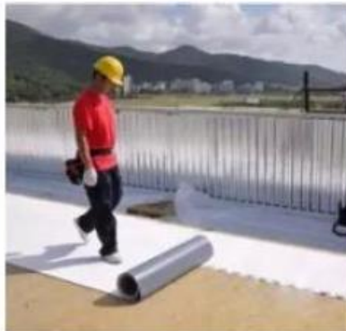
lay the membrane
